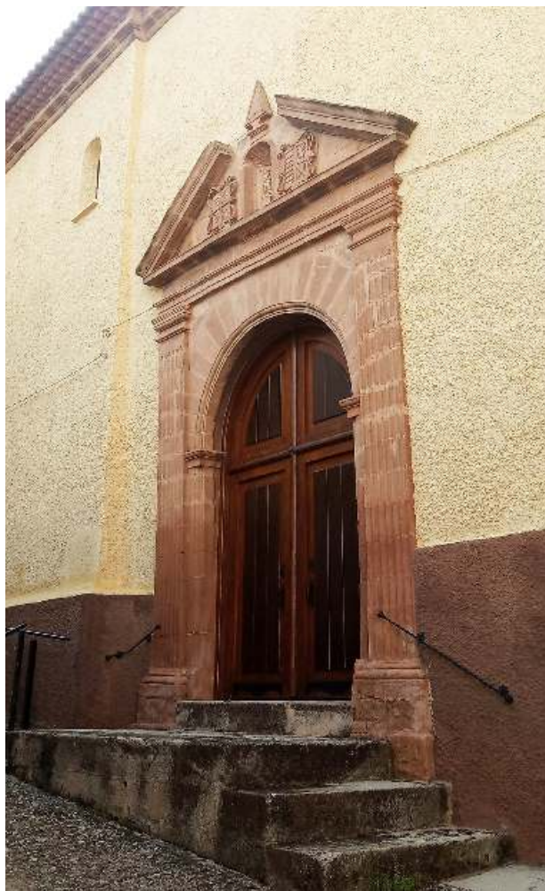
Figura 17. Fachada de la iglesia del convento de Santa María Magdalena con los escudos en el frontón de la portada.
