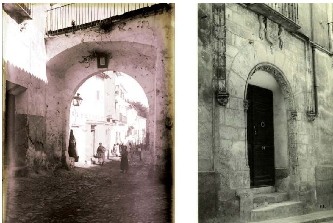
Figura 46. Imagen de la antigua casa de los Muñoz. A la derecha después de la reforma de los años 60 del siglo XX cuando se restructuró la fachada incorporando un nuevo elemento: la portada con arco y escudo. Fotografía izquierda de Pedro Román a principios del siglo XX. R-115-3-01 y R-143-3-02. Derecha, M. Segura. AHP, signatura 75.791, 1.
